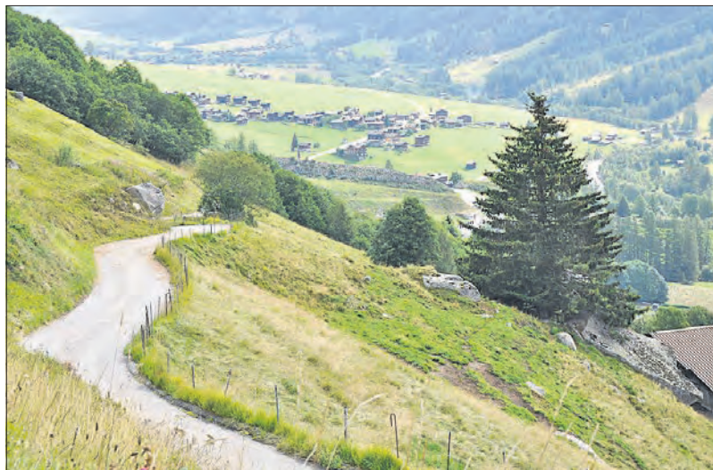
Die Forststrasse im Bieligertal muss saniert werden.
