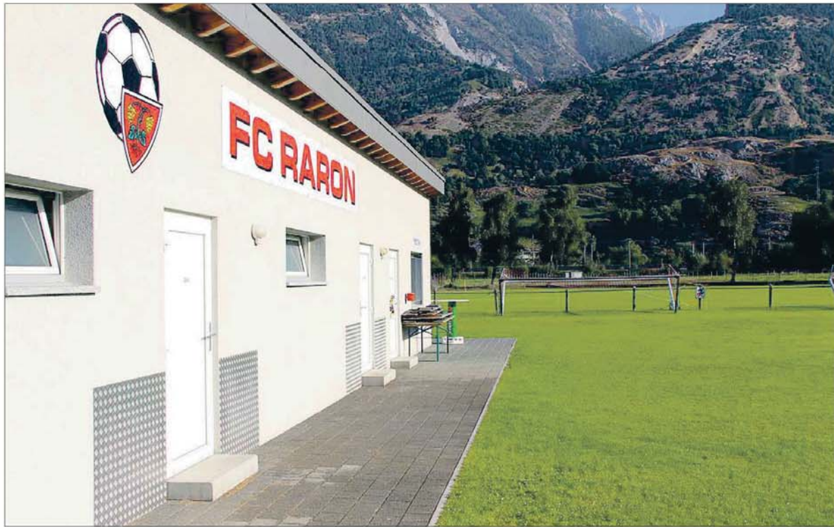
«Moos» statt «Turtig». Geht es nach dem EHC Raron, könnte auf dem Sportplatz «Moos» in Raron eine Eishalle gebaut werden.
