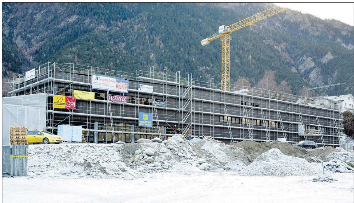
Die Geschina Arena wird im Sommer fertiggestellt, darum sucht man derzeit einen Betriebs- und einen technischen Leiter.
