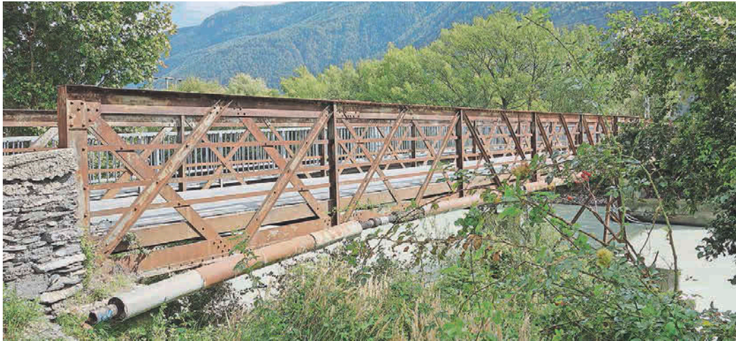
Die Tage der Rottenbrücke in Raron sind gezählt. Ab 2019 soll mit dem Neubau begonnen werden.
