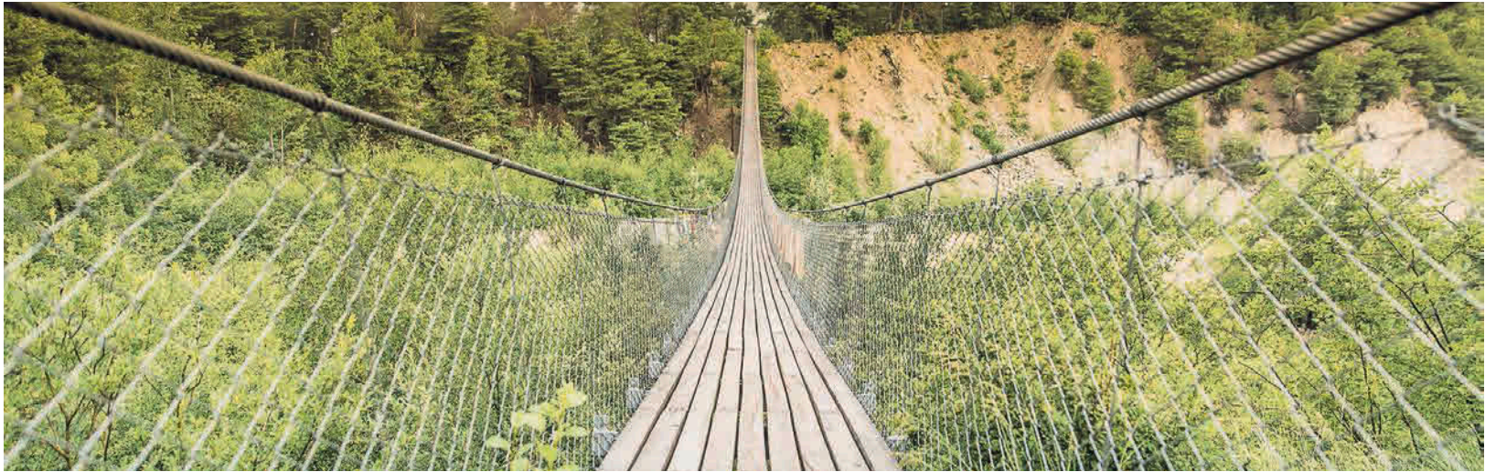
Die Bhutanbrücke über den Illgraben wird frühestens Mitte Mai wieder für die Wanderer freigegeben.
