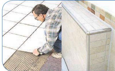
Während dem 5., 6. und 7. Tag werden Wandschlitz und Unebenheiten in Ihrem Mauerwerk beseitigt und alle Flächen für das Fliesen vorbereitet. Die Dusche und Badewanne werden gestellt und angeschlossen. Danach wird der Fliesenleger diese ausmauern, sowie die Wände als auch den Boden verfliesen und ausfugen.
