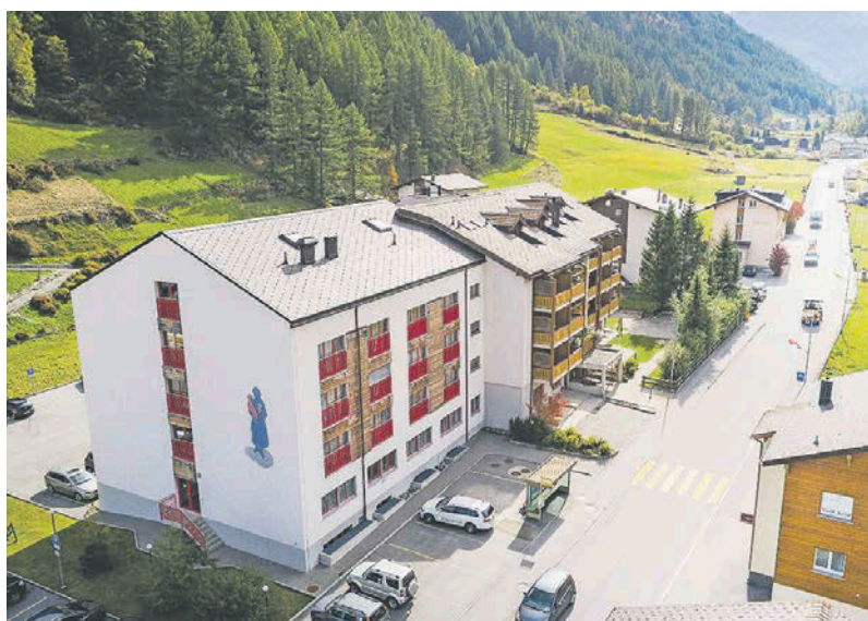
Das Trottoir beim Altersheim St. Antonius in Saas-Grund soll schon bald saniert werden.
