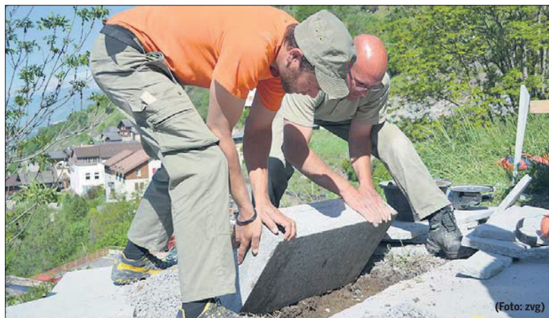
Die Zivilschützer legen Hand an und helfen bei der Instandstellung von Wanderwegen.
