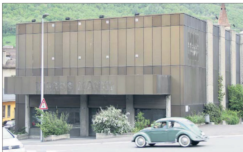
Idealer Standort. Das Gebäude eingangs Visp steht schon lange leer.
