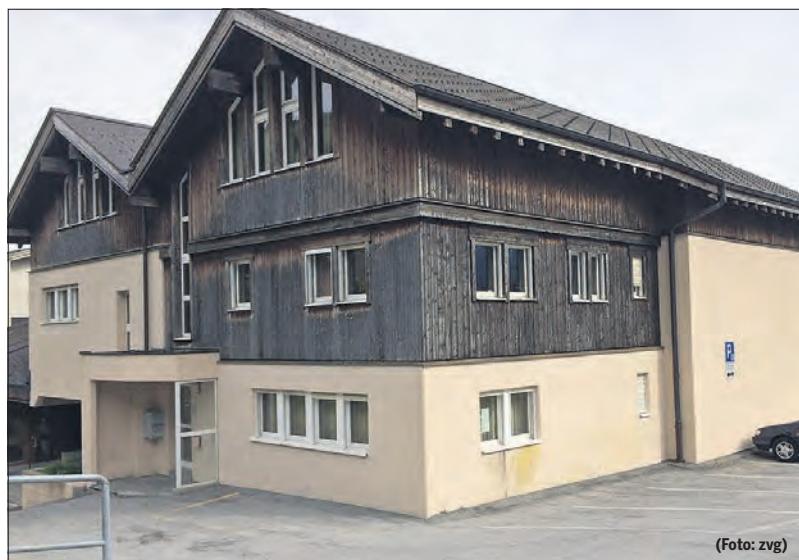
Die Gemeinde Leuk will das alte Schulhaus in Erschmatt mit neuem Leben füllen.
