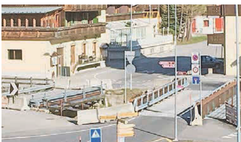
Die Rottenbrücke in Oberwald.
