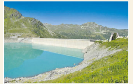
Die Staumauer von Cleuson. zvg
