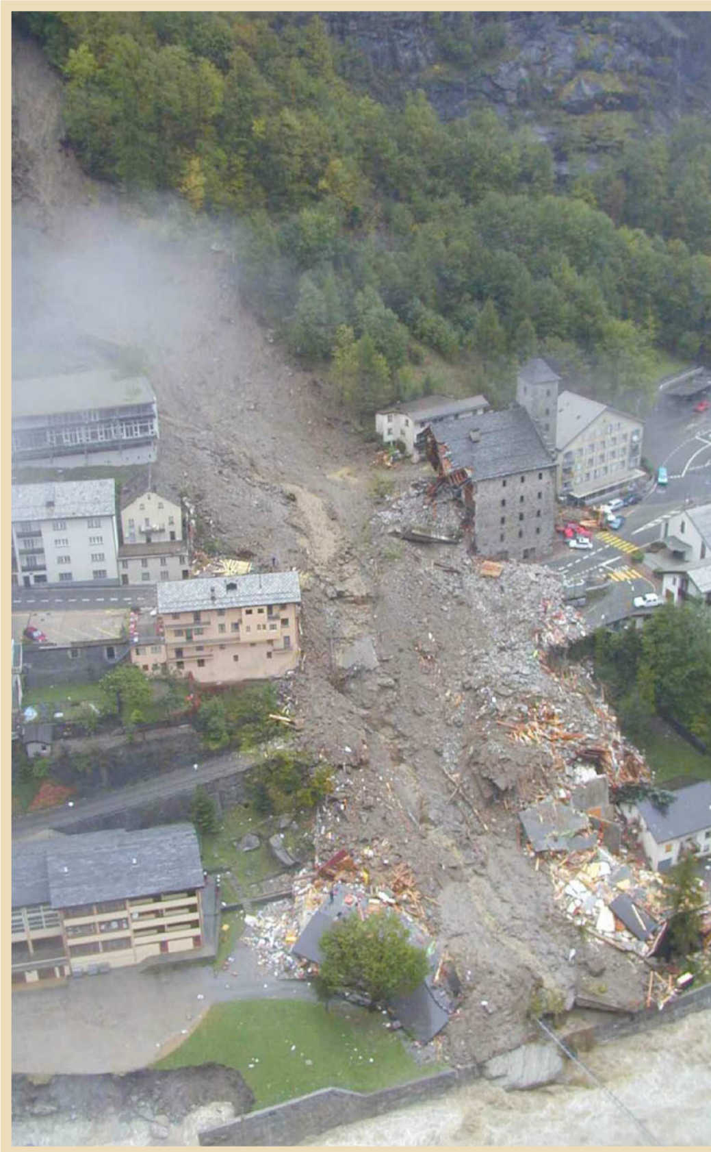
Der Schlamm und die Felsen reissen einen Teil des Dorfes Gondo mit. 14 Menschen verlieren ihr Leben. Wohngebäude werden mitgerissen; der Stockalperturm wird teils zerstört. zvg
